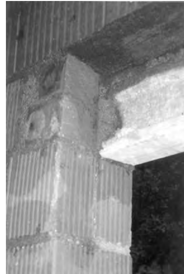
En el interior nos queda espacio suficiente como para introducir la caja de persiana
