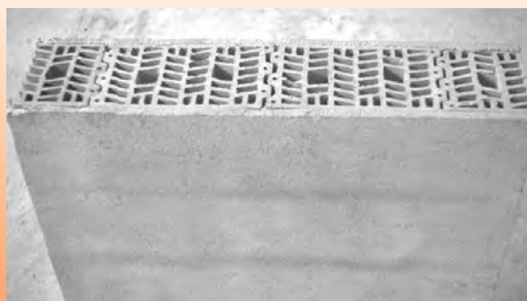
Junta vertical entre bloques ejecutada correctamente
