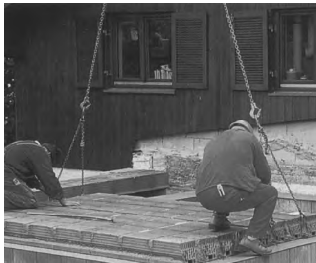
Forjado con placa cerámica pretensada
