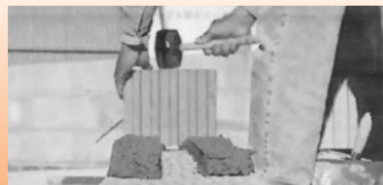
Sentar los bloques verticalmente y golpear con una maza de goma las piezas para conseguir que el mortero penetre en las perforaciones
