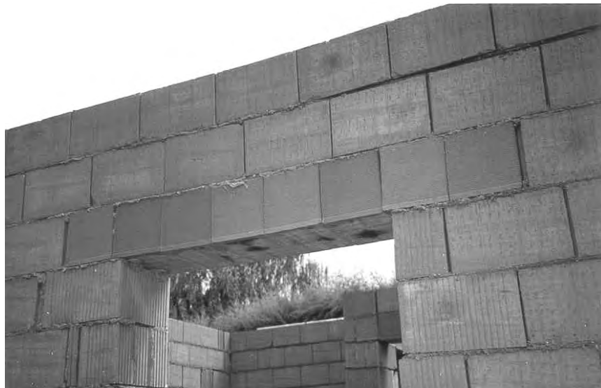
Apoyo adecuado del cargadero
