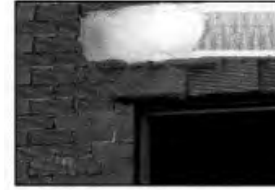
Cortar trozos de malla de 20x40 cm y colocarlos en diagonal sobre cada ángulo del marco
