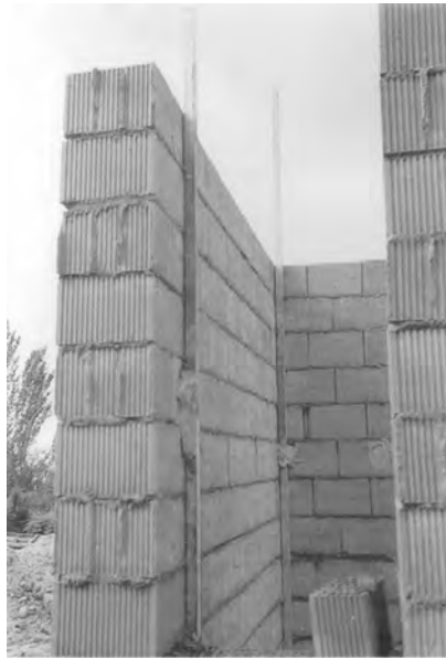
Colocación de miras
