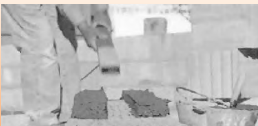
Retirar la regla para proceder a la colocación de los bloques
