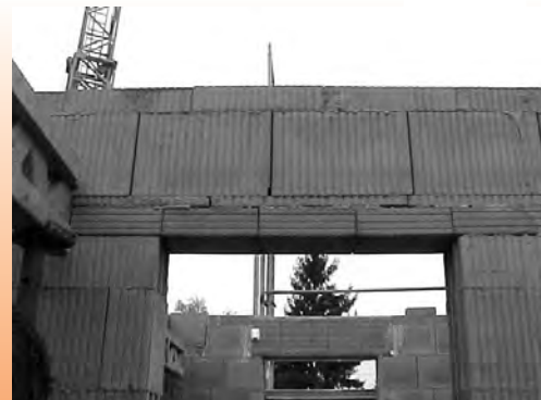
Piezas cortadas en el dintel del hueco
