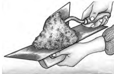
El yeso se coloca con la paleta sobre la llana...
