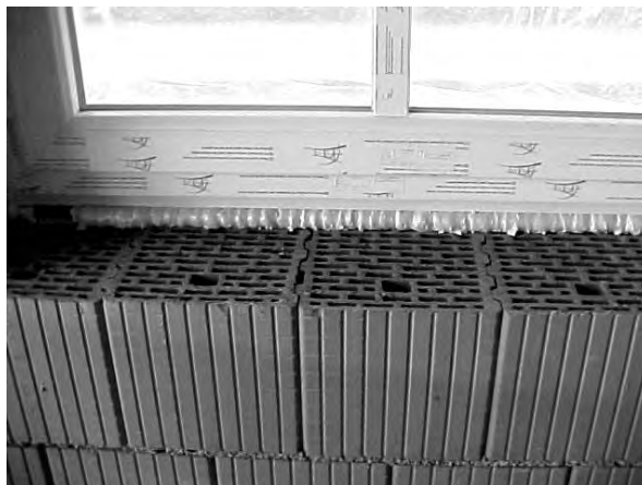
Carpintería colocada a haces exteriores
