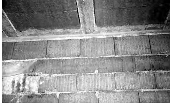
Canto del zuncho mayor que el canto del forjado
