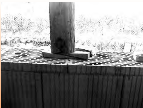
Piezas cortadas en el antepecho del hueco
