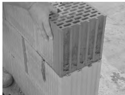
Empleo de piezas cortadas en el muro
