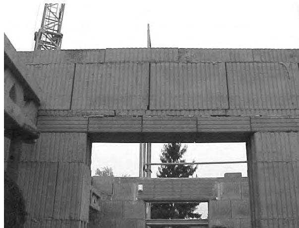
Cargadero con vigueta cerámica armada
