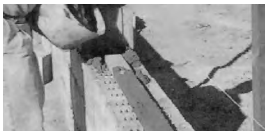
En muros exteriores de una sola boja, el tendel de mortero se realizará de forma discontinua
