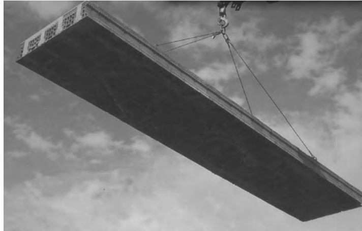
Placa cerámica pretensada elevada mediante grúa
