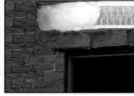
Recubrir totalmente las cajas de persiana con la malla y 20 cm cada unión de la misma con un cerramiento
