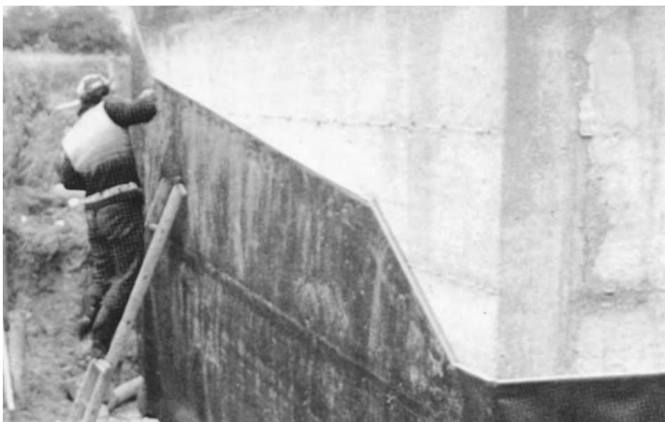
Impermeabilización de un muro de cimentación con lámina asfáltica
