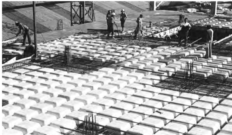
Vista general de un forjado reticular con moldes recuperables
