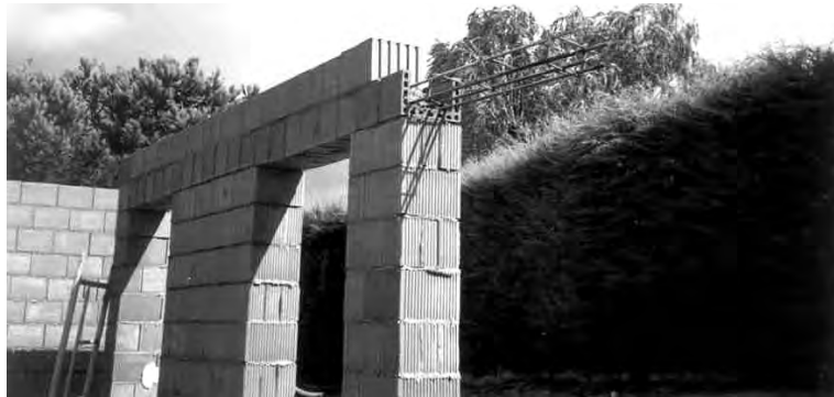
Cargadero común a varios huecos muy próximos
