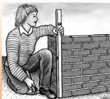
La vertical se comprueba con el nivel de burbuja
