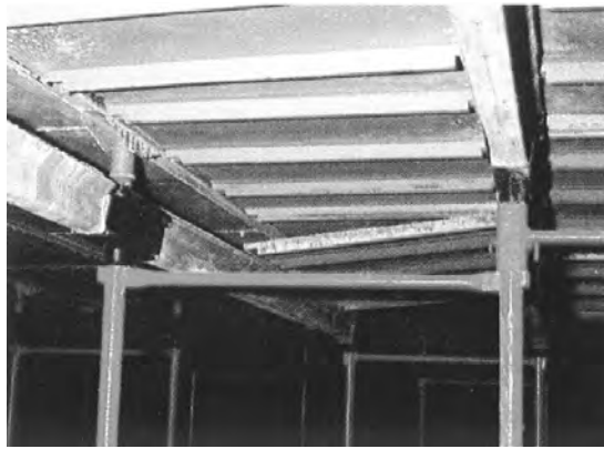
Sistema de encofrado recuperable a base de planchada, quedando todo el techo liso
