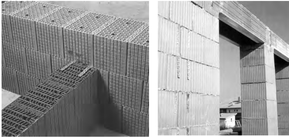
Empleo de llaves y pletinas metálicas para realizar la unión de los muros
