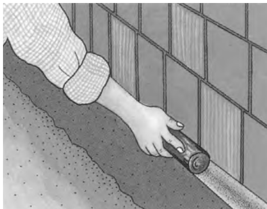
El mortero se alisa con una botella, con lo que se consigue un redondeo uniforme y liso
