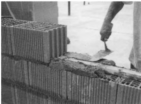
Situar un listón de 3x5 apoyado sobre la cara mayor en medio de la hilada
