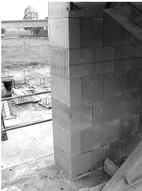
Jamba ejecutada correctamente
