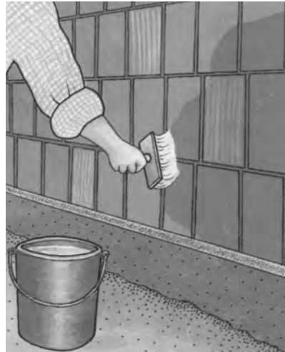
Antes del emplastecido, hay que aplicar una imprimación al muro
