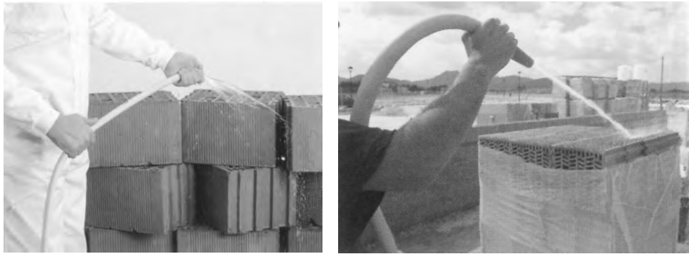
Humedecer los bloques Termoarcilla antes de su colocación
