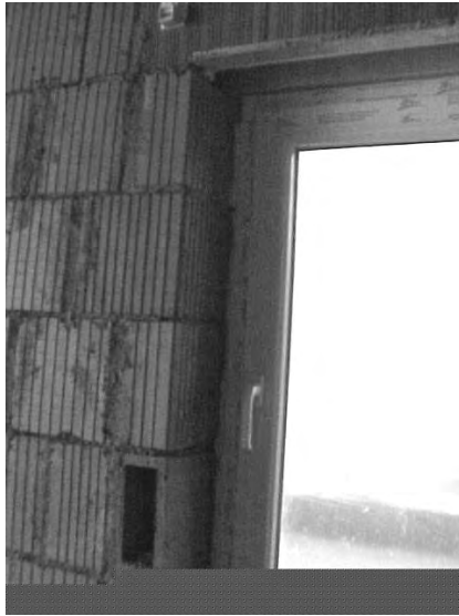
En el interior nos queda espacio suficiente como para introducir la caja de persiana
