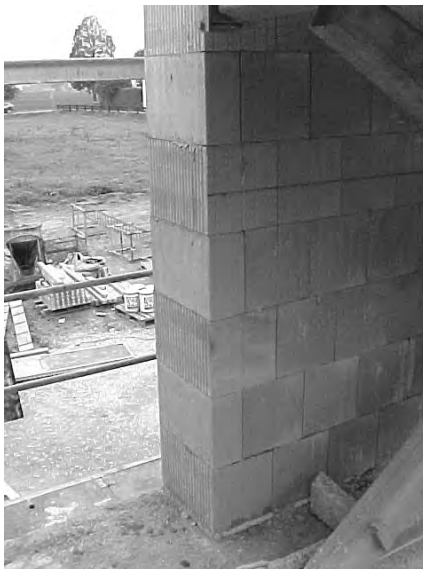
Jamba del hueco empleando piezas especiales
