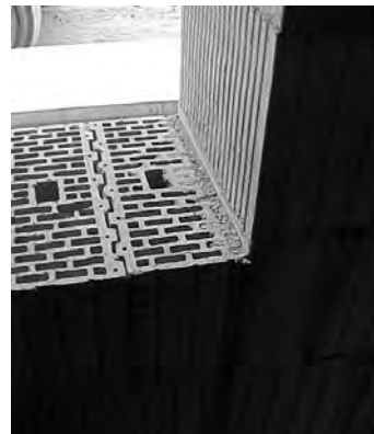
Junta vertical entre bloques ejecutada correctamente
