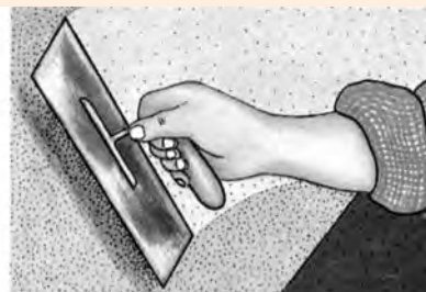
Con el fratás se frota toda la superficie en círculos
