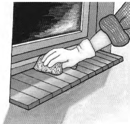
Las juntas se enlechan, y luego se limpia cuidadosamente el vierteaguas
