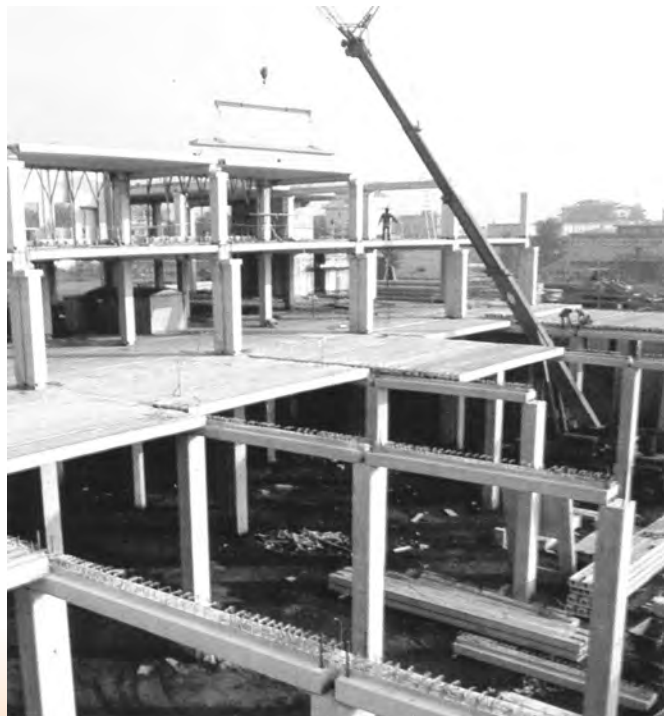
Pavimento construido a base de losas prefabricadas de hormigón armado
