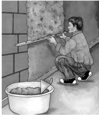
Revestimiento de los muros Termoarcilla
