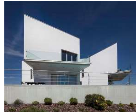
Vivienda unifamiliar Las Rozas (Madrid)
