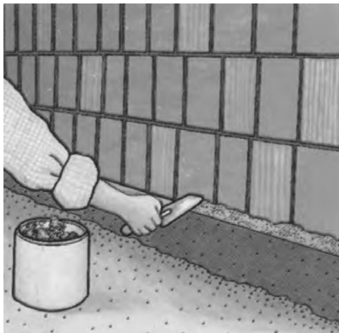
El retranqueo entre el cimiento y el muro se rellena con mortero
