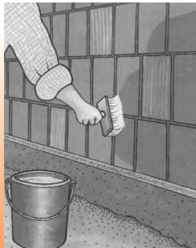
Si la base es muy absorbente, se aplica primero una imprimación
