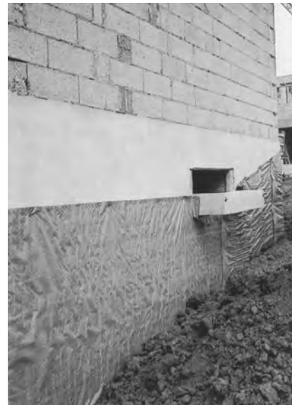
Protección del drenaje en muros de cimentación con capa protectora
